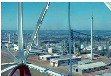
Figura 4 – Vista da Usina Protótipo do Xisto Irati, a partir de Plataforma Intermediária da Estrutura da Tocha
