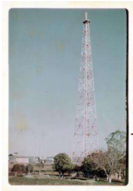
Figura 01 – Vista da Tocha com Estrutura Vertical de Suporte
