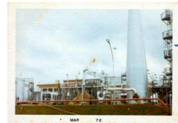
Figura 8 – Vista da Unidade de Recuperação de Enxôfre - URE
