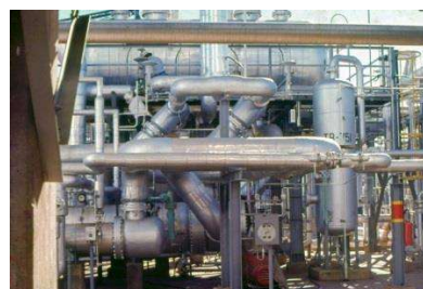
Figura 5 - Mostra o Tambor de Gás Ácido, os Condensadores de Enxofre, os Aquecedores de Linha e os Reatores da Unidade de Recuperação de Enxôfre - URE
