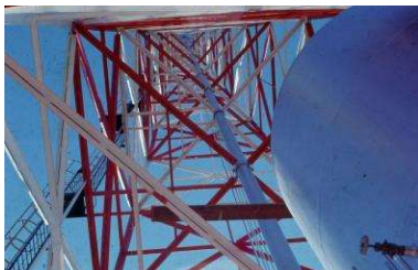
Figura 3 – Vista Interna da Estrutura da Tocha, mostrando parte superior do Vaso Separador Gás-Líquido e Tubulação do Gás de Alimentação da Tocha
