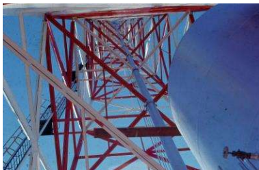
Figura 3 – Vista Interna da Estrutura da Tocha, mostrando parte superior do Vaso Separador Gás-Líquido e Tubulação do Gás de Alimentação da Tocha
