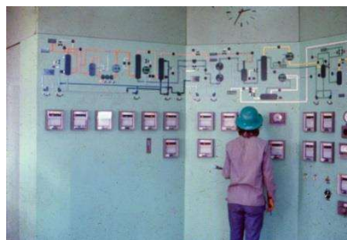
Figura 10 – Vista parcial do Painel Gráfico mostrando o Fluxo de Processo e Instrumentação da Unidade de Tratamento de Gás Ácido - UTGA
