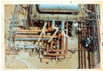
Figura 2 – Aquecedores de Linha da Unidade de Recuperação de Enxôfre - URE
